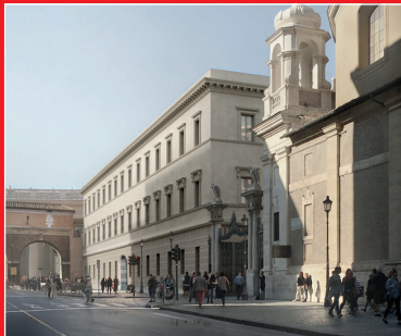
fig. 7 Conservation de la façade vers l'Italie
